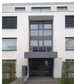
Treppe und Aussenwand
