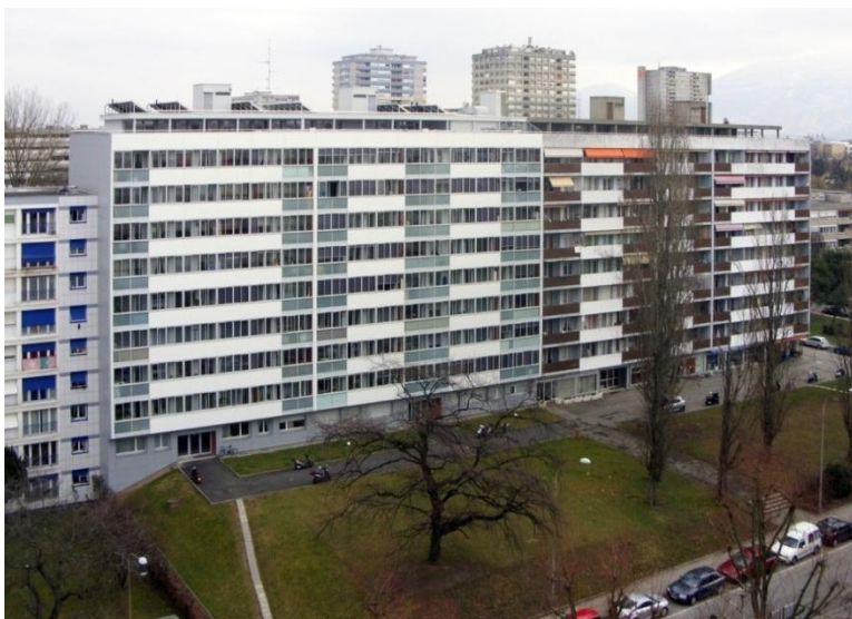
Vue de la façade sud-ouest (côté rue)
