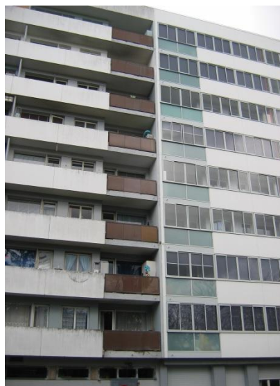
A gauche (non renové), à droite (renové)
