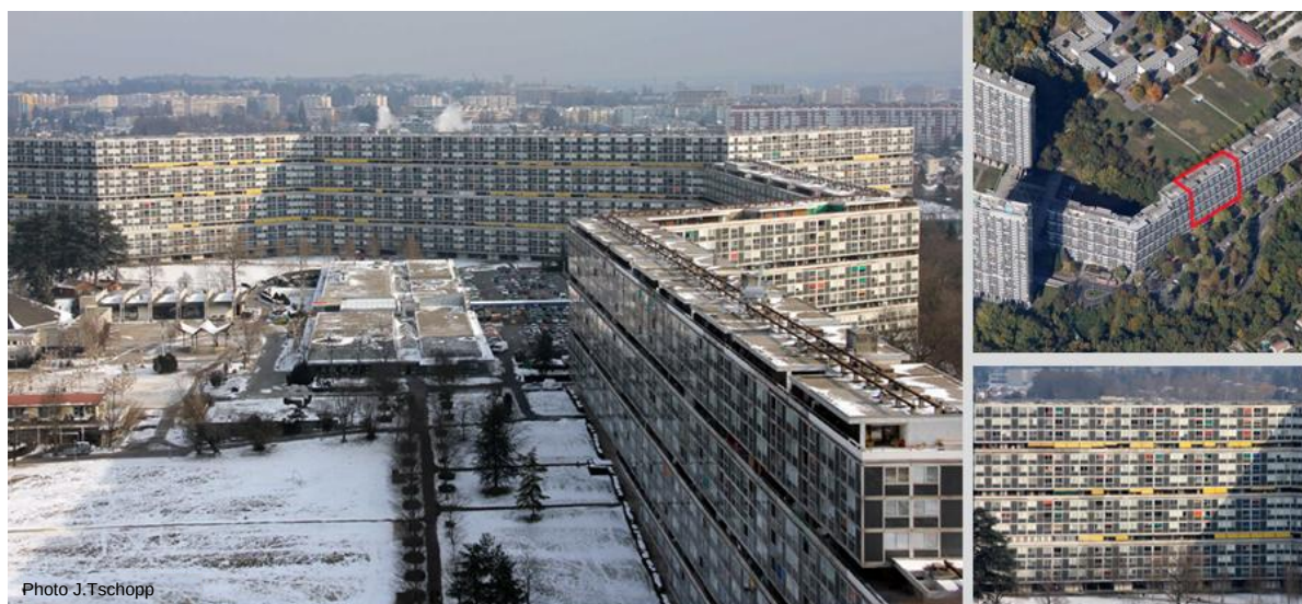
Figure 2.34. Vue d'ensemble de la Cité satellite du Lignon construite dans les années soixante en périphérie de la Ville de Genève et protégée depuis 2009 par un plan de site. Les allées n°20 à 24 sont représentées à droite de la figure
