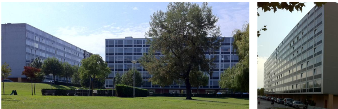
Figure A6.3. Façades légères des ensembles Meyrin Parc et Le Ciel Bleu à Meyrin (1960-1964)
