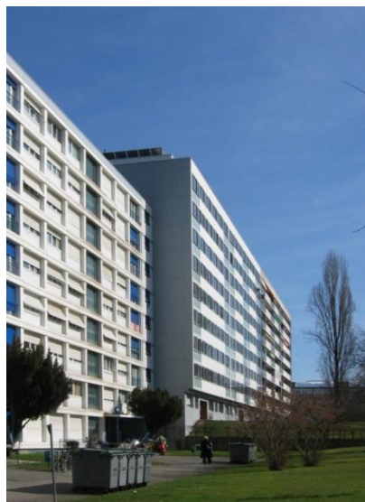
Vue de la façade nord-ouest (pignon)
