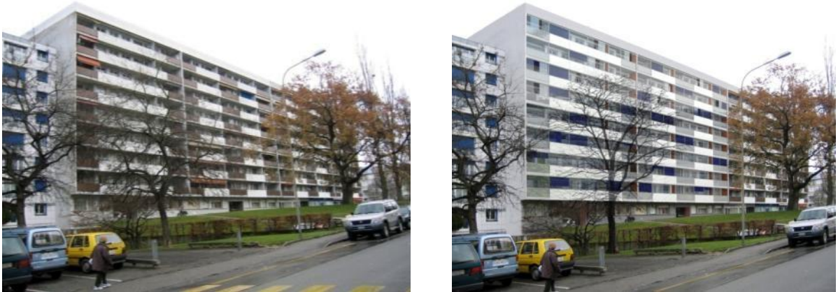
Figure 4.12. Façades sud-ouest avant rénovation (à gauche) et après rénovation (à droite)
